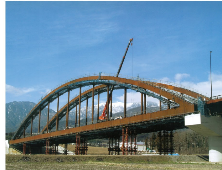
鋼ローゼ桁橋 業界：道路 寸法：142m×20m 材質：SM400・SS400 重量：266t
